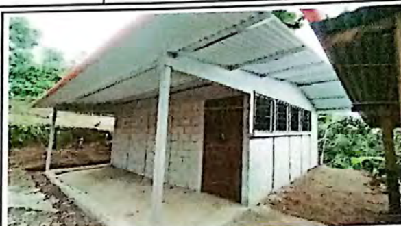
Suministro e instalación de estructura para techo con techo de lamina troquelada/acanalada aluzinc cal 26, Suministro e Instalacion de puerta de metal con chapa Yale 1x2.5 m.
