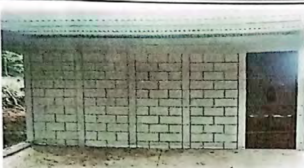
Suministro e instalación de paredes prefabricadas para aula.
