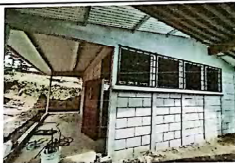
Suministro e instalación de ventana 1x1 m.
