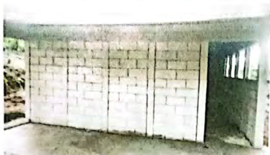
Suministro e instalación piso de concreto.
