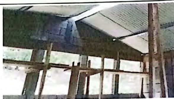
Suministro e instalación de ventana 1x1 m.
