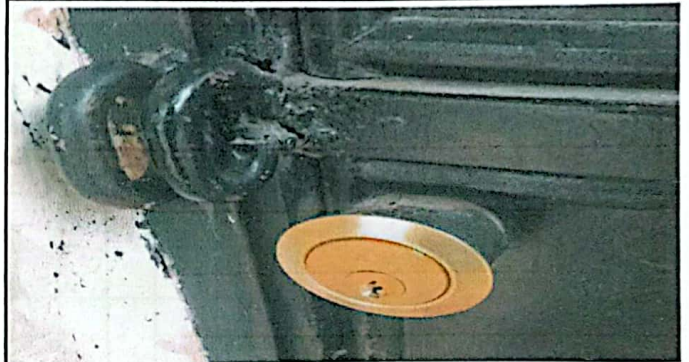
Foto 4: MANTENIMIENTO DE CHAPAS.
