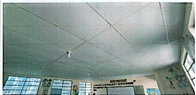
Foto 6: INSTALACIÓN DE CIELO FALSO EN DIRECCIÓN Y EN EL AULA.
