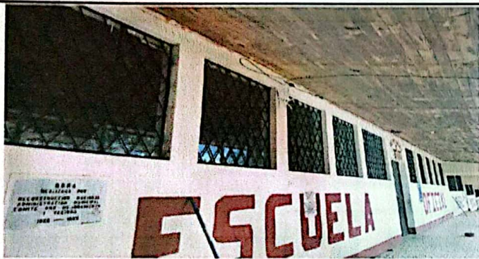
Foto 3: MANTENIMIENTO DE BARANDAS.
