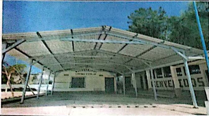
Foto 1: VISTA DE INSTALACIÓN DE LÁMINA EN EL PATIO.
