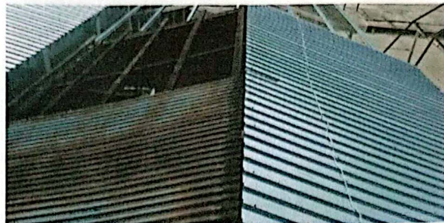
Foto 2: SUSTITUCIÓN DE LÁMINAS EN AULAS.
