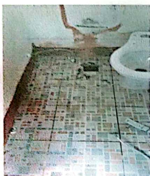
Foto 3: CAMBIO DE TAZAS EN LOS SANITARIOS.
