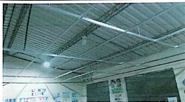
Foto 4: COLOCACIÓN DE CIELO FALSO.
