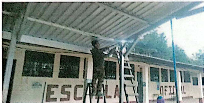
Foto 1: COLOCACIÓN DE LÁMINA EN EL PATIO.
