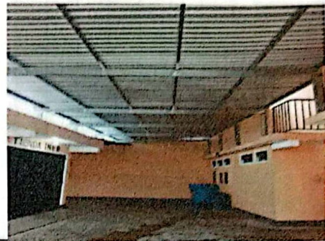
Foto 2: VISTA DE INSTALACION DE LAMINA FINALIZADO
