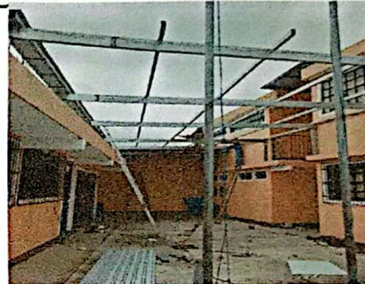
Foto 4: SUMINISTRO E INSTALACIÓN
