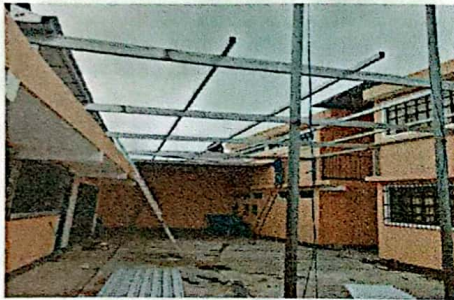
Foto 3: SUMINISTRO E INSTALACIÓN
