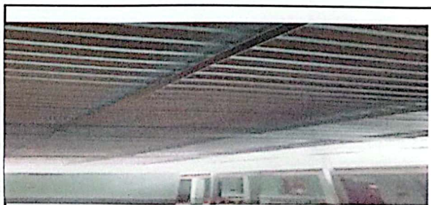
Foto 6: SUMINISTRO E INSTALACIÓN DE LAMINAS FINALIZADO
