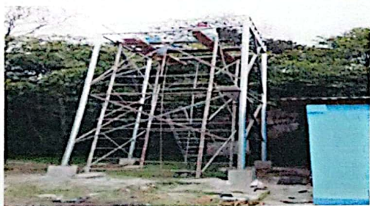
Foto 5: ESTRUCTURA PARA DEPOSITO DE AGUA POTABLE.
