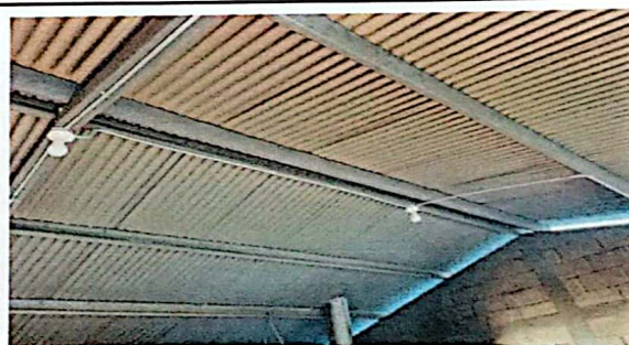
Foto 3: MANTENIMIENTO DE SISTEMA ELECTRICO
