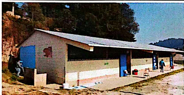
Foto1: EN PROCESO LA PINTURA
