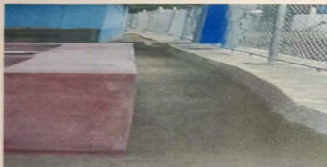
SUMINISTRO Y SUSTITUCION DE PARED DE CONTENCIÓN
