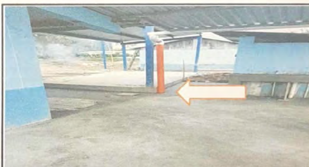
INSTALACION DE TUBERIA DE 4" PARA DESFOGUE
