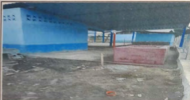
SUSTITUCION DE ESTRUCTURA PORTANTES + ENTECHADO DE AREA DE PILA
