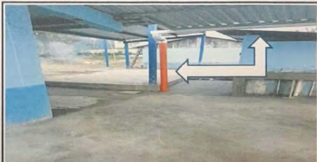
INSTALACION DE CANAL PLUVIAL + BAJADAS DE AGUA PLUVIAL CON TUBO DE 4"
