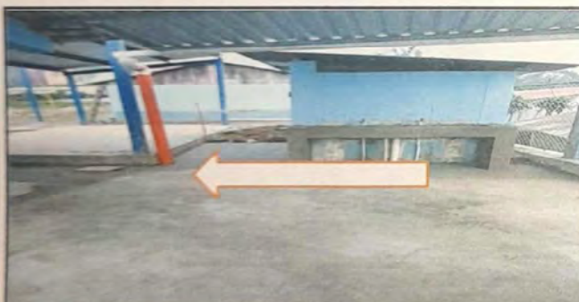
REPARACION DE CAJA DE CONCRETO DE DESFOGUE
