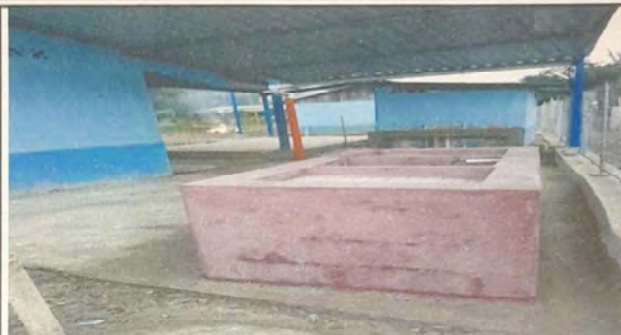
SUSTITUCION DE PILA DE CONCRETO
