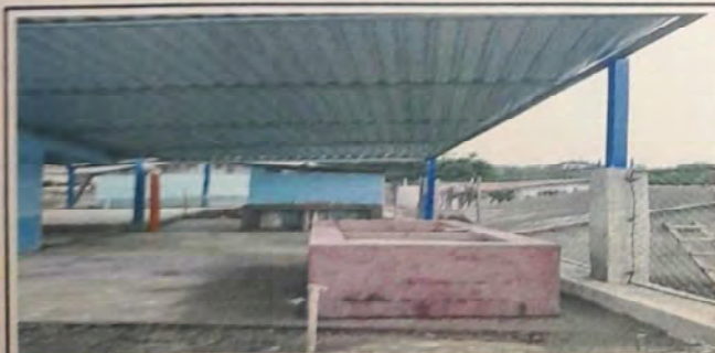
SUSTITUCION DE PISO DE CONCRETO DE 8 CM
