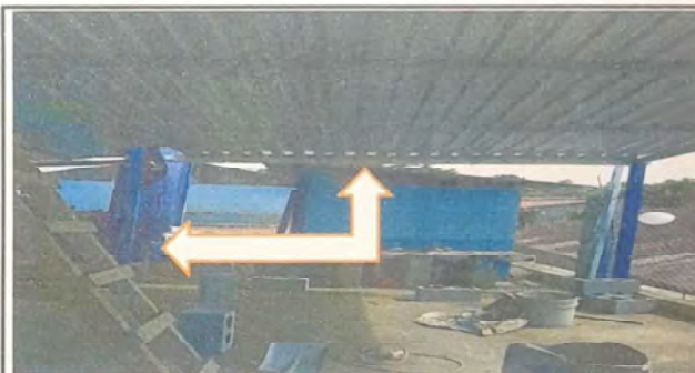
INSTALACION DE TUBERIA DE 4" PARA DESFOGUE
