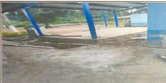
REPARACION DE CAJA DE CONCRETO DE DESFOGUE
