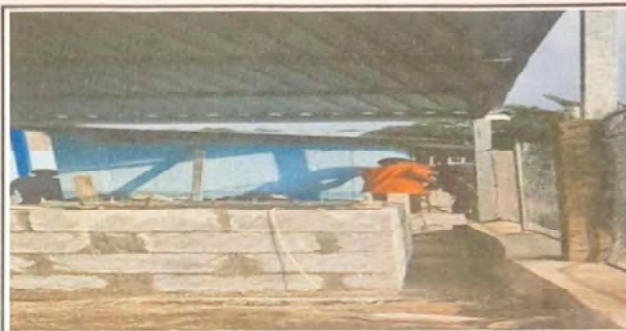
SUSTITUCION PILA DE CONCRETO
