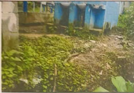
SUMINISTRO Y SUSTITUCION DE MURO DE CONTENCIÓN
