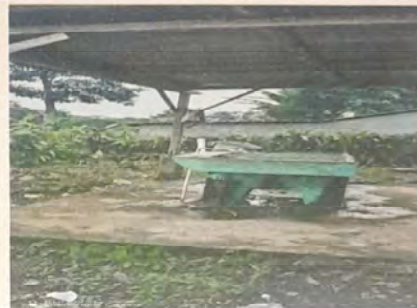
SUSTITUCION DE PILA DE CONCRETO
