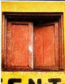
Suministro e instalación de balcones.
