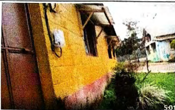
Mantenimiento a muro de aulas, limpieza de pintura más repello a paredes exteriores.
