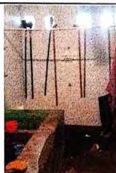
Suministro e instalación de pared en baños
