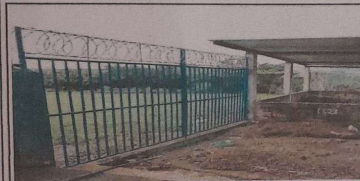
Foto 3: SUSTITUCION DE PORTON AL 100%
