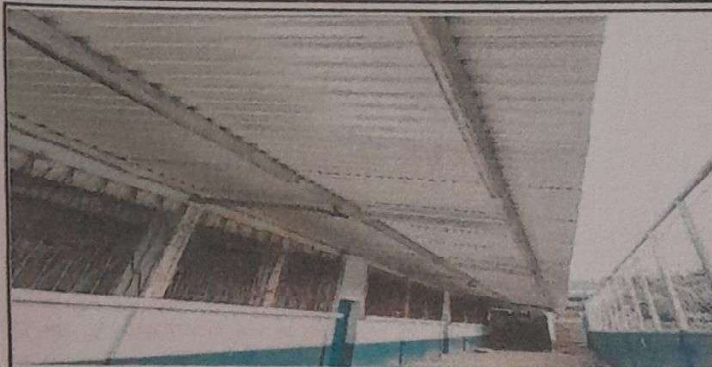
Foto1: VISTA FACHADA INTERIOR LAMINA COLOCADA AL 100%
