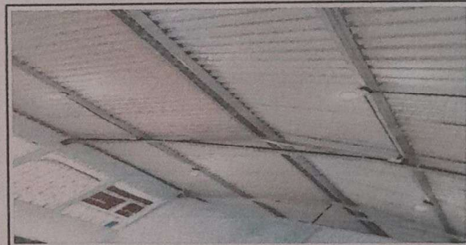
Foto 4: VISTA DE SUMISTRO E INSTALACION DE LA ENEGIA ELECTRICA EN SU TOTALIDAD
