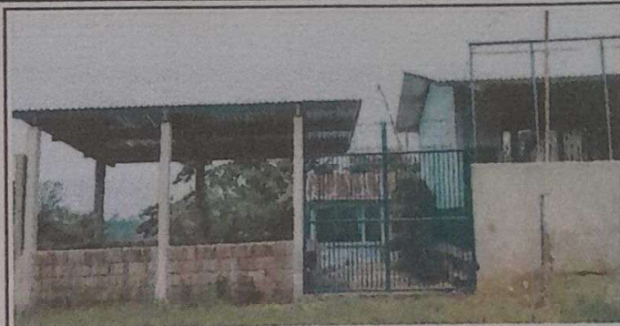
Foto 2: VISTA DE INSTALACIÓN DE LÁMINA FINALIZADO
