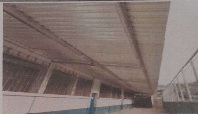
Foto 2: SUMINISTRO E INSTALACIÓN DE LÁMINA PRIMERA FASE
