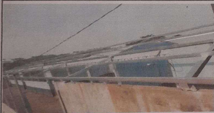
Foto 3: SUMINISTRO E INSTALACIÓN DE ESTRUCTURA METALICA NUEVOS
