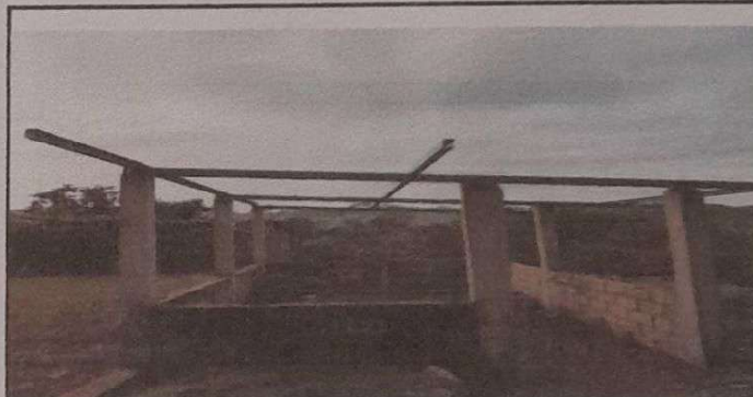
Foto 4: CAMBIO DE LAMINAS DE LA COCINA
