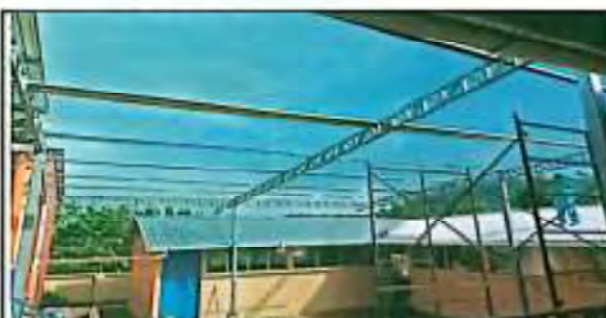
Foto 6: Describir la actividad de la fotografía: se realizó la estructura metalica para el segundo entechado
