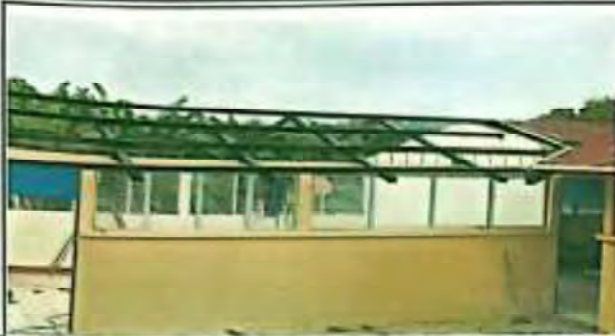
Foto 1: Describir la actividad de la fotografía: Se inicio con el cambio de techos de las tres aulas ya que se encontraban ya deterioradas
