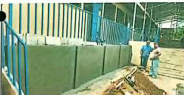
Foto 5: Describir la actividad de la fotografía: se realizó una pared de contencion
