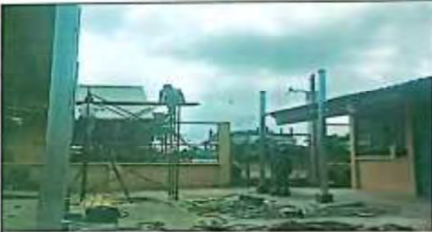
Foto 4: Describir la actividad de la fotografía: se inicio con la colocacion de la estructura metalica para el techo del patio de la escuela
