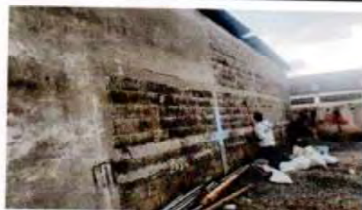
Suministro, trabajo en 79 mts2: limpieza y aplicación de impermeabilizante para exterior parte trasera de 2 aulas
