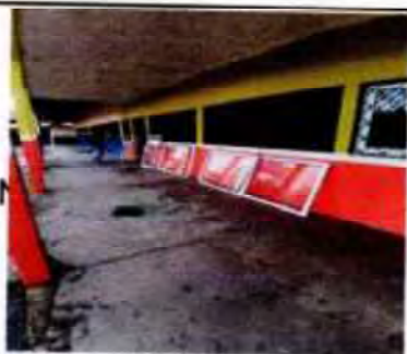
Suministros, fabricación e instalación de ventanas corredizas de pvc blanco con vidrio claro de 5mm 2.80 x 1.04
