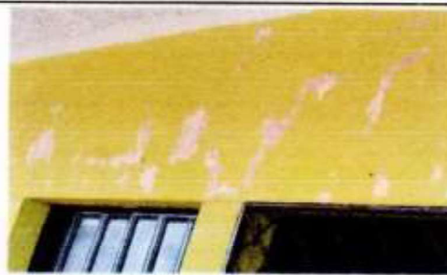
Suministro, trabajo, limpieza y aplicación de pintura de agua en el exterior únicamente parte de enfrente de 1 aula
