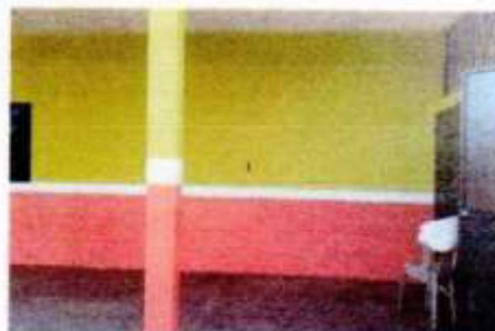
Abertura de vano de puerta. 1.00 X 2.10
