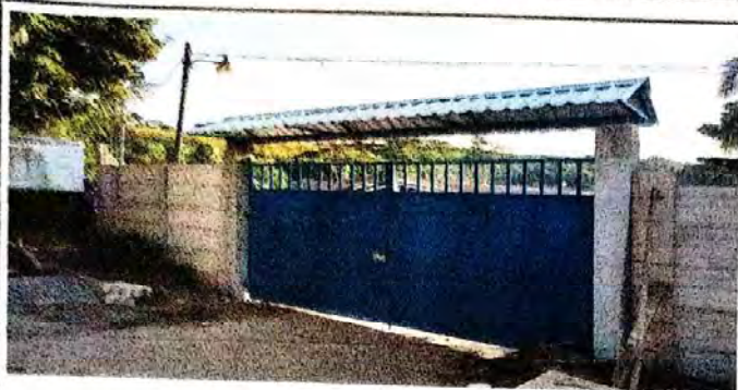
Foto1: SUMINISTRO E INSTALACION DE PORTON
