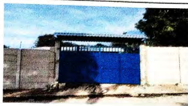
Foto 2: SUMINISTRO E INSTALACION DE PORTON
