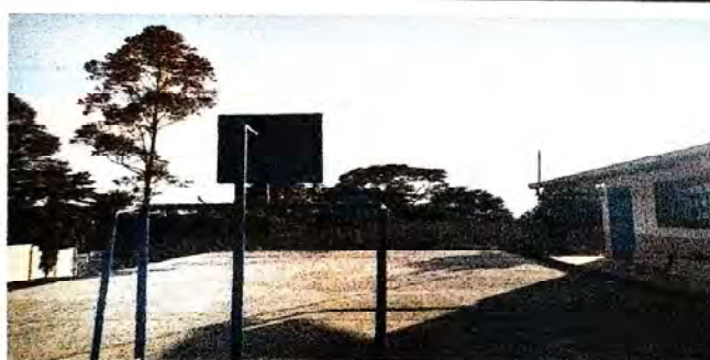
Foto 3: SUMINISTRO E INSTALACION DE PORTERIAS.
