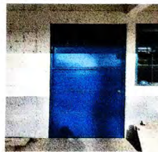
Foto 6: SUSTITUCION DE PUERTAS DE METAL PARA AULAS.
