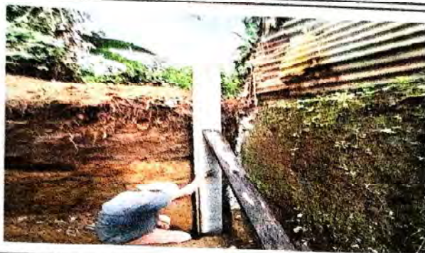
Foto 1: SUMINISTRO E INSTALACION DE MURO PERIMETRAL
