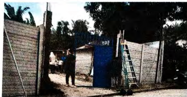
Foto1: SUMINISTRO E INSTALACION DE PORTON.
