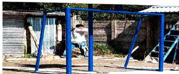
Foto 3: SUMINISTRO E INSTALACION DE PORTERIAS EN CANCHA
