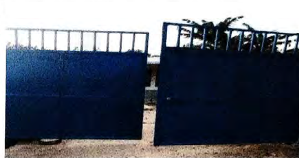
Foto 2: SUMINISTRO E INSTALACION DE PORTON.
