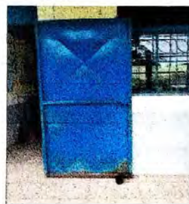
SUSTITUCIÓN DE PUERTA DE METAL PARA AULAS
