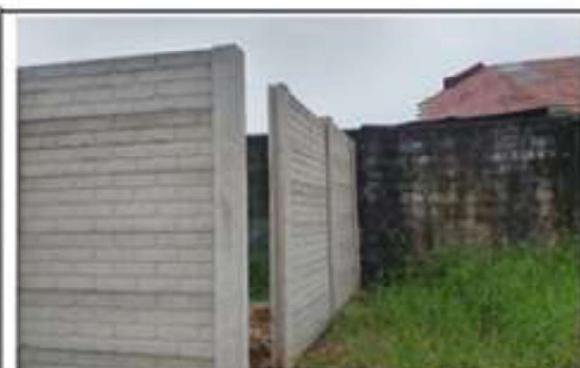
Foto 3: MURO AMBOS LADOS
