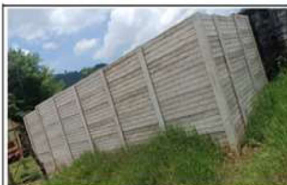
Foto 4: SUMINISTRO E INSTALACIÓN DE MURO PREFABRICADO
