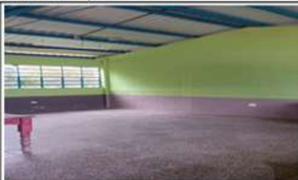
Foto 1: SUMINISTRO DE PINTURA EN LAS PAREDES
