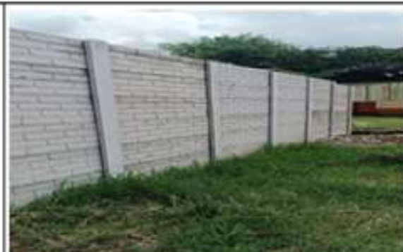
Foto 2: MANTENIMIENTO DE MURO CON COBERTURA DE VANO
