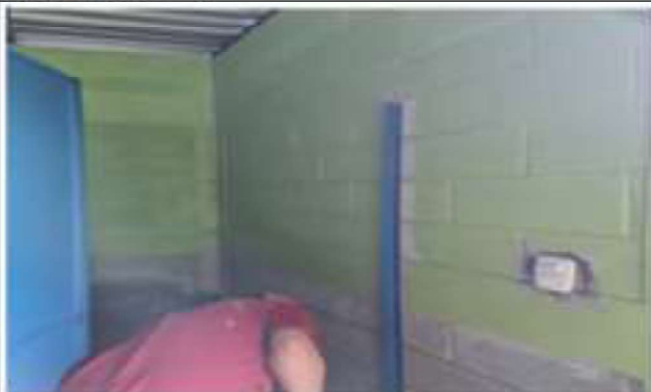
Foto 1: SUMINISTRO DE PINTURA EN LAS PAREDES
