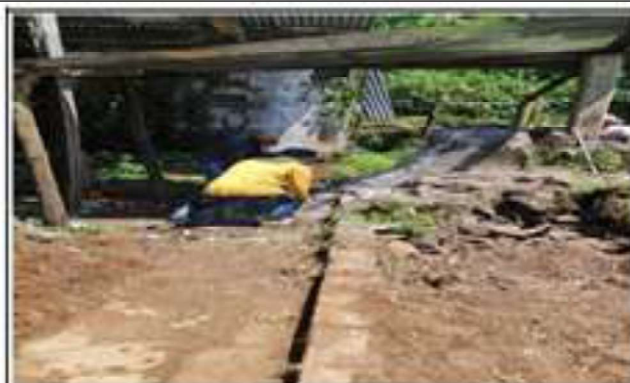
Foto 2: DURANTE LA COLOCACIÓN DEL MURO
