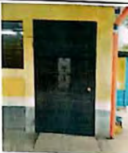
Reparación de puerta de metal
