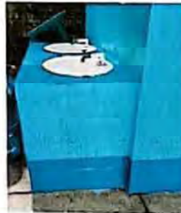
Suministro y reparación de grifos en lavamos
