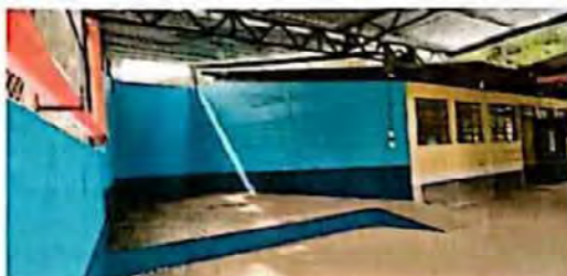
ro e instalación de lamina troquelada calibre 26
