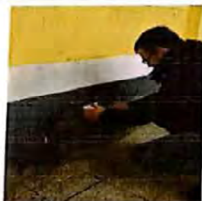
Suministro y sustitucion de sistema electrico
