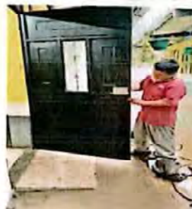
Reparacion de puerta de metal
