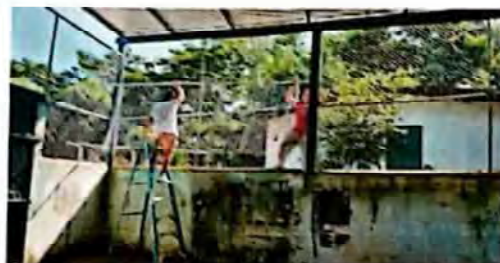
Suministro y aplicación de pintura de aceite en muro perimetral
