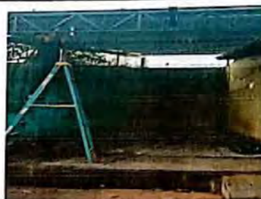
ro e instalacion de lamina troquelada calibre 26
