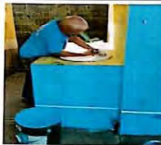
Suministro y reparación de grifos en lavamos
