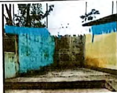
ro e instalacion de lamina troquelada calibre 26
