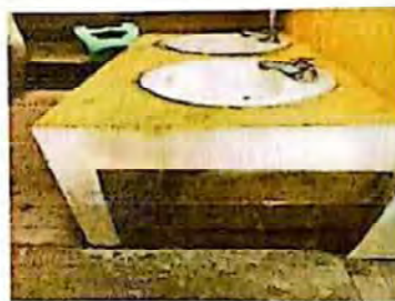
Suministro y reparación de grifos en lavamos
