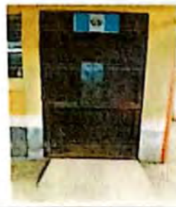
Reparacion de puerta de metal
