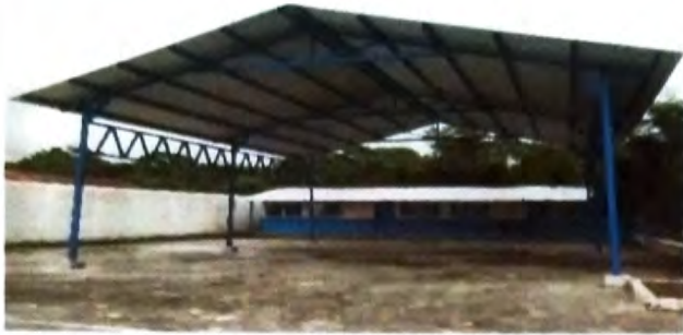
Foto1: VISTA INTERIOR DE ESTRUCTURA METÁLICA CON ANTICORROSIVO COLOCADA AL 100%
