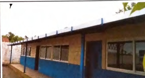
Foto 4: VISTA DE LADO DE SUMINISTRO E INSTALACIÓN DE CANAL DE METAL
