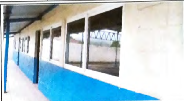
Foto 2: VISTA DE INSTALACIÓN DE VENTANAS FINALIZADAS
