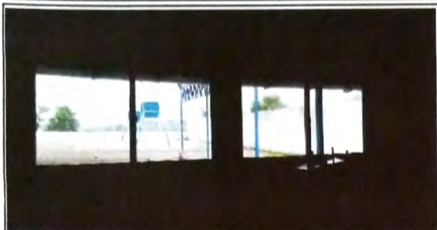
Foto1: VISTA INTERIOR DE VENTANAS COLOCADAS AL 100%
