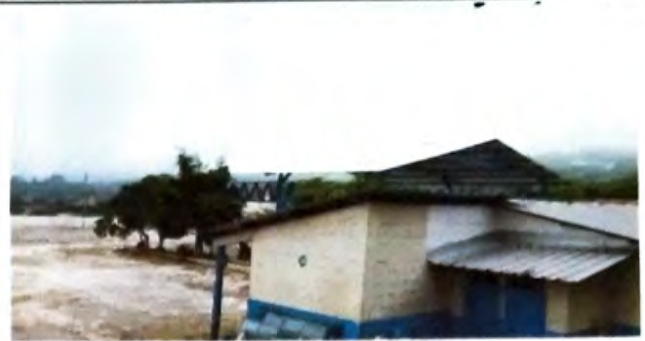
Foto 2: VISTA EXTERIOR E INSTALACIÓN DE ESTRUCTURAS METÁLICA CON ANTICORROSIVO FINALIZADO
