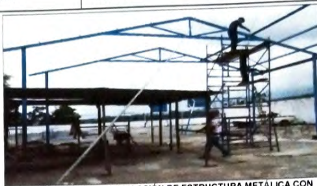
Foto 2: SUMINISTRO E INSTALACIÓN DE ESTRUCTURA METÁLICA CON ANTICORROSIVO PRIMERA FASE
