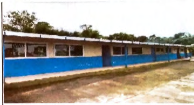
Foto 4: COLOCACIÓN DE CANAL DE METAL
