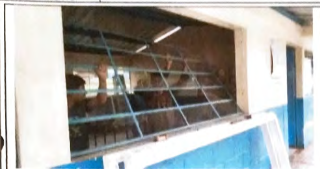
Foto 1: RETIRO DE VENTANAS ANTIGUAS DE METAL
