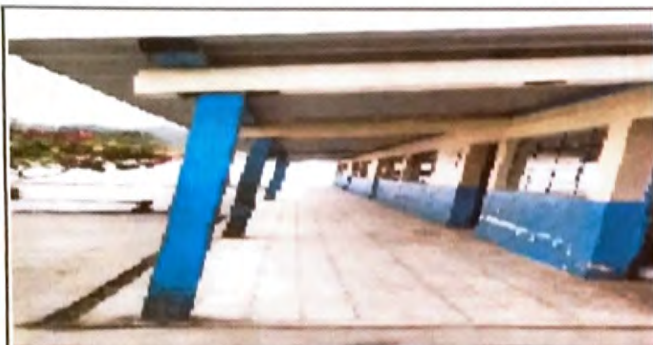
Foto 3: SUMINISTRO E INSTALACIÓN DE CANAL DE METAL
