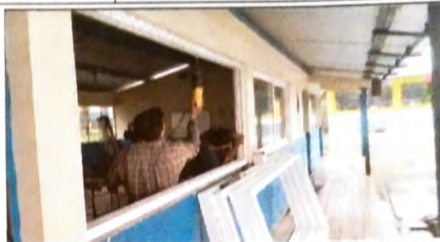
Foto 2: SUMINISTRO E INSTALACIÓN DE VENTANA DE PVC PRIMERA FASE
