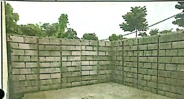
SUMINISTRO DE MATERIALES E INSTALACION DE MURO PREFABRICADO DE 12.35 ML * 2.80 M
