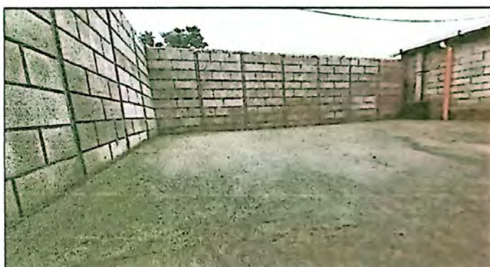
CORTE Y NIVELACION + FUNDICION DE MEZCLON DE CONCRETO
