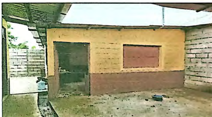
SUMINISTRO + APLICACIÓN DE PINTURA
