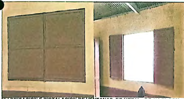
FABRICACION E INSTALACION DE VENTANAS DE METAL, DE 1*1.50 CON PASADORES
