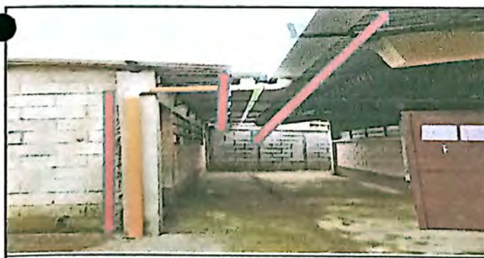
SUMINISTRO E INSTALACION DE CANAL PLUVIAL
