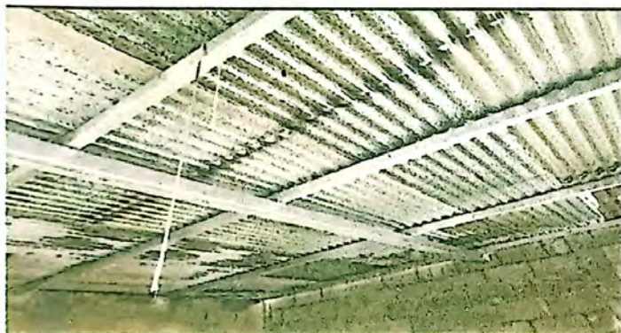
SUMINISTRO E INSTALACION DE ESTRUCTURA PORTANTE CON COSTANERA DE 3"2 GALVANIZADA
