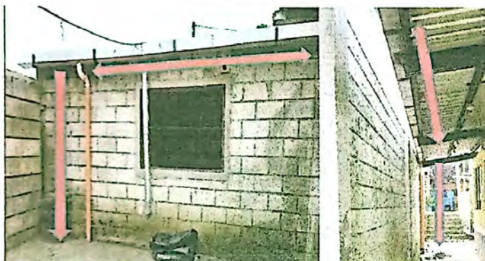
SUMINISTRO E INSTALACIÓN DE CANAL PLUVIAL DE 0.20*0.25
