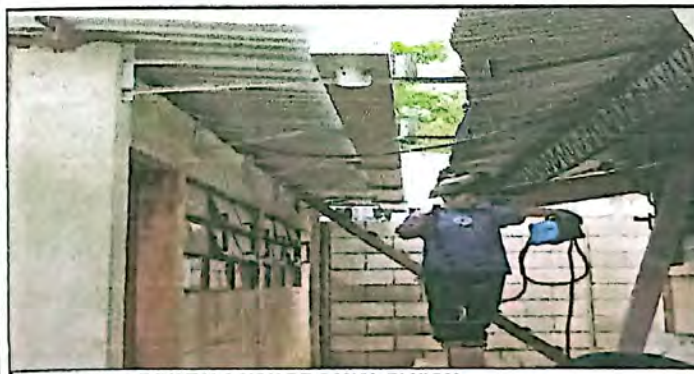
SUMINISTRO E INSTALACION DE CANAL PLUVIAL
