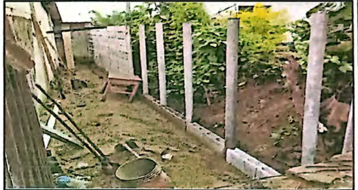
SUMINISTRO DE MATERIALES E INSTALACION DE MURO PREFABRICADO DE 11.40 ML * 2.80 M
