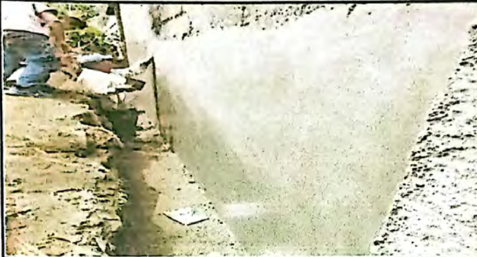
REMOZAMIENTO DE PARED COLINDANTE REPELLO + ALISADO + NYLON NEGRO
