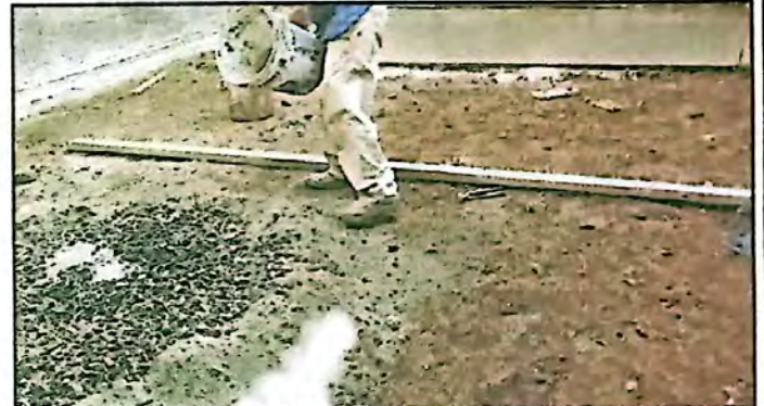
CORTE Y NIVELACION + FUNDICION DE MEZCLON DE CONCRETO
