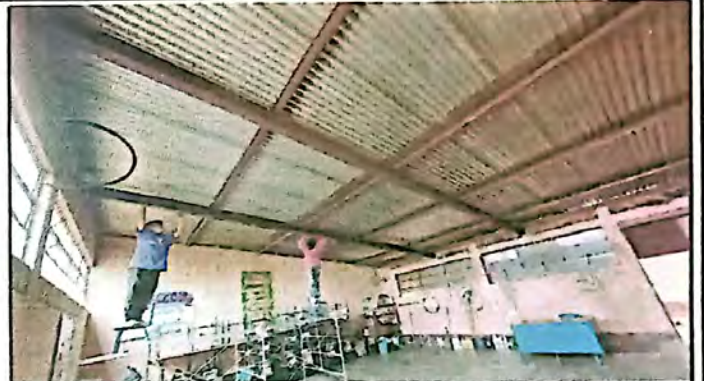
SUMINISTRO E INSTALACION DE CUBIERTA METALICA CON LAMINA TROQUELADA CALIBRE 26
