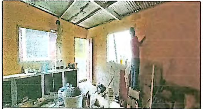
SUMINISTRO + APLICACIÓN DE PINTURA
