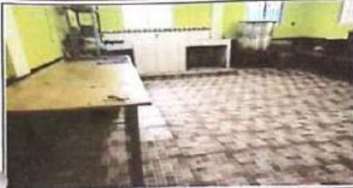
Foto 1: Sustitución de piso en la cocina finalizado.
