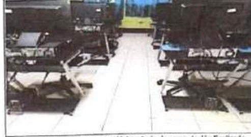
Foto 2: Sustitución de piso en el laboratorio de computación finalizado.
