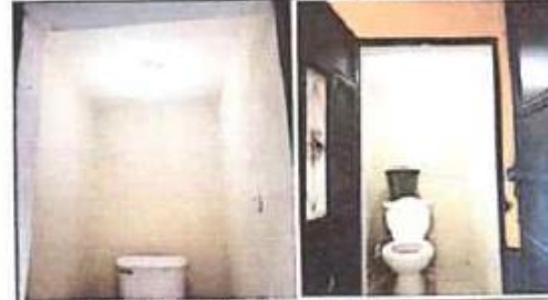
Foto 4: Instalación eléctrica luminaria, finalizado.
