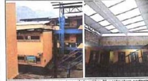
Foto 6: Sustitución de lámina trequelada calibre 26 y estructura portante de metal, finalizado.
