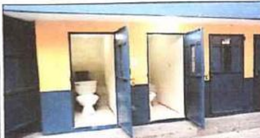
Foto 3: Sustitución de inodoros, mantenimiento de puerta de metal, finalizado.
