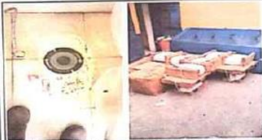
Foto 3: Sustitución de inodoros, mantenimiento de puerta de metal.
