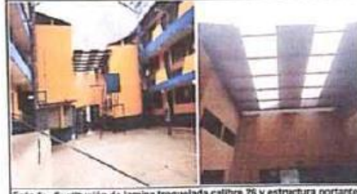
Foto 6: Sustitución de lamina troquelada calibre 26 y estructura portante de metal.
