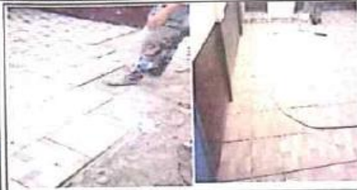
Foto 1: Sustitución de pisos en la cocina
