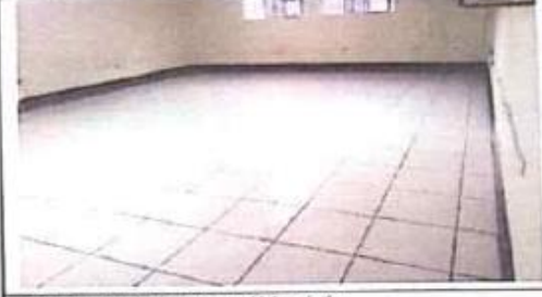
Foto 2: Sustitución de pisos en el laboratorio.
