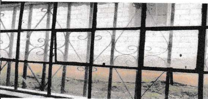
Foto 3: VISTA DE LA FINALIZACION DE LA COLOCACION DE VIDRIOS EN VENTANALES
