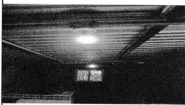
Foto 4: FINALIZA LA COLOCACIÓN DE ENERGIA ELECTRICA EN COCINA
