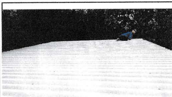
Foto 3: SUMINISTRO E INSTALACIÓN DE LAMINA EN EL TECHO
