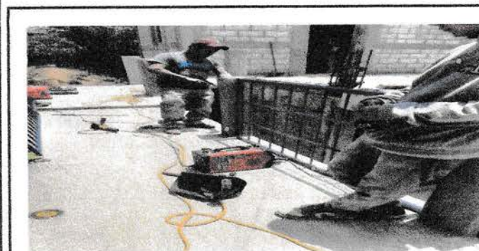
Foto 5: SUMINISTRO E INSTALACIÓN DE BARANDAS DE PASILLOpp
