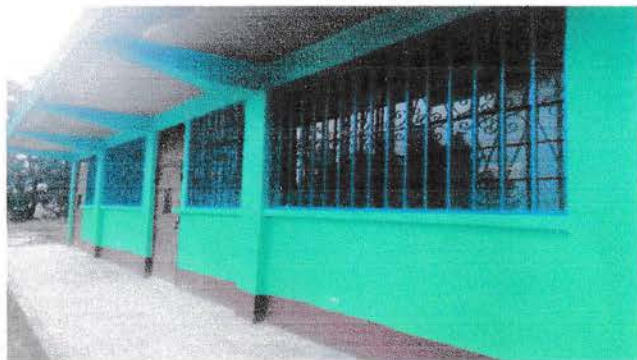
Renglón 1: SUMINISTRO E INSTALACIÓN DE BALCONES FINALIZADO
