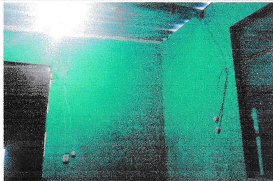
Nuevo Renglón de trabajo: Suministro e Instalación de energía eléctrica en dos aulas y dirección.
