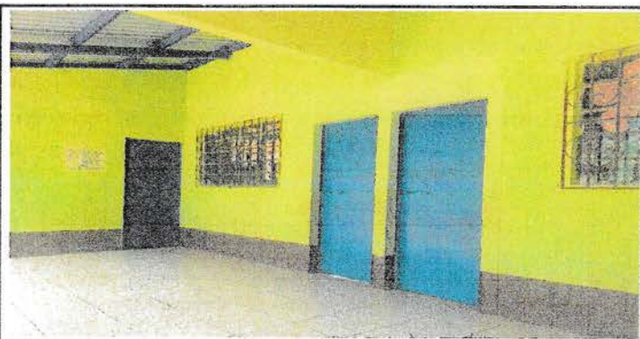
Foto 3: MANTENIMIENTO DE PUERTAS METALICAS
