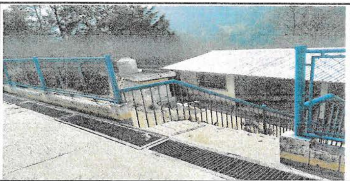
Foto 5: SUMINISTRO Y APLICACIÓN DE PINTURA PERIMETRAL Y MANTENIMIENTO DE BARANDA METÁLICA
