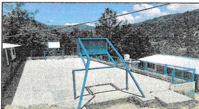
Foto 4: MANTENIMIENTO DE PORTERIAS METALICAS
