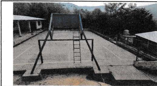
Foto 5: SUMINISTRO Y APLICACIÓN DE PINTURA PERIMETRAL
