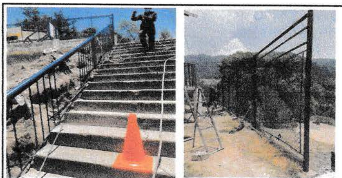
Foto 6: MANTENIMIENTO DE BARANDA METALICA Y MURO PERIMETRAL DE MAYA GALVANIZADA
