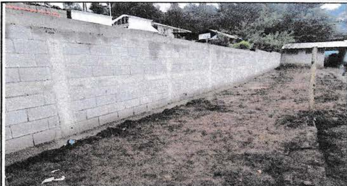
Foto 2: VISTA INTERIOR DEL MURO TERMINADO AL 100%
