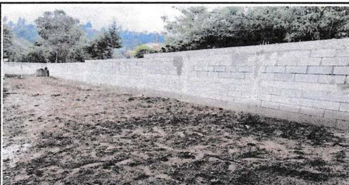
Foto 3: VISTA INTERIOR DEL MURO TERMINADO AL 100%
