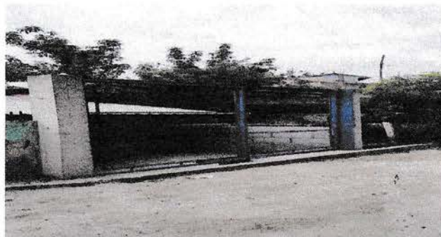
Foto 6: VISTA DEL PORTÓN INSTALADO AL 100%
