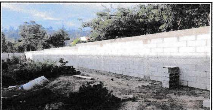
Foto 6: FINALIZACIÓN DE COLACIÓN DE BLOCK Y CORONA DE CONCRETO
