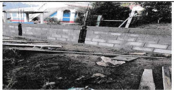
Foto 5: SUMINISTRO E INSTALACIÓN DE SOLERA DE HUMEDAD INTERMEDIA
