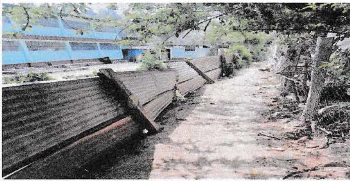
Foto1: RETIRO DE LÁMINAS ANTIGUAS
