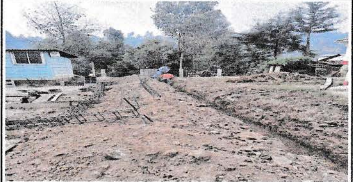
Foto 2: SUMINISTRO E INSTALACIÓN DE CIMENTO CORRIDO
