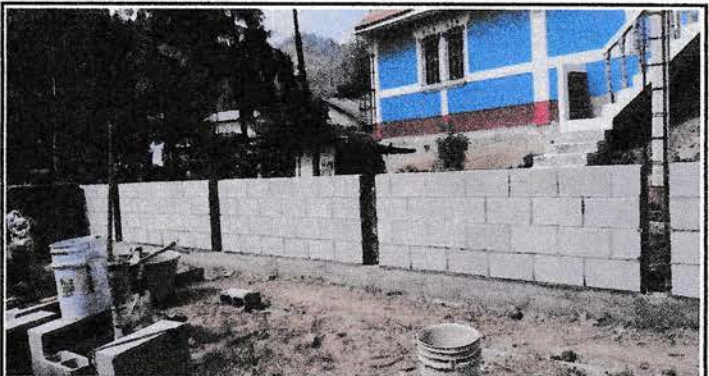
Foto 4: SUMINISTRO E INSTALACIÓN DE PRIMERA FASE DE BLOCK
