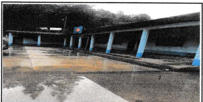
Foto 6: VISTA EXTERIOR DE LAS AULAS, SUMINISTRO Y APLICACIÓN DE PINTURA FINALIZADA.
