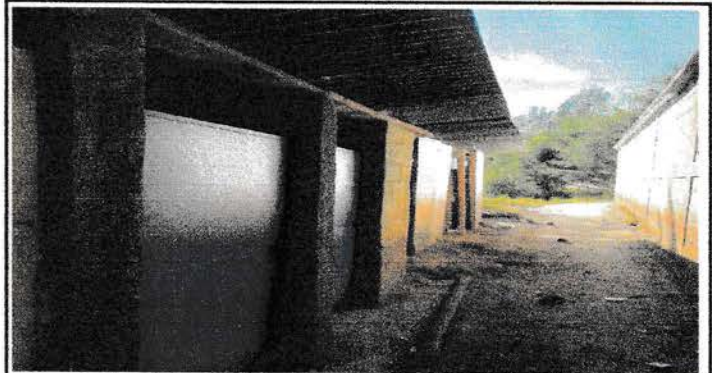
Foto 2: VISTA DE INSTALACIÓN DE DOS PUERTAS DE METAL, LAMINA PARA LA MEJORA DE LA ESTRUCTURA DE LOS BAÑOS.
