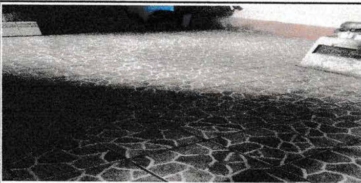
Foto 5: INTERIOR DE LA COCINA CON SUMINISTRO E INSTALACIÓN DE PISO CERAMICO ANTIDESLISANTE FINALIZADA.
