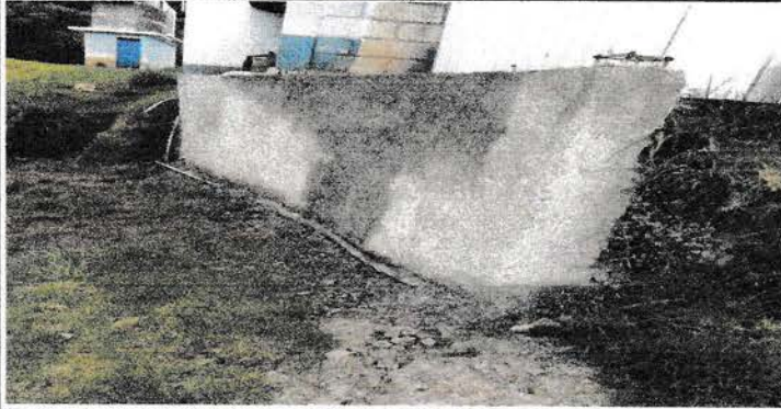
Foto 1: SUMINISTRO E INSTALACIÓN DE MURO FINALIZADO
