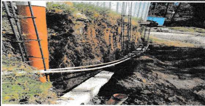
Foto 1: SUMINISTRO E INSTALACIÓN DE MURO DE CONTENCIÓN
