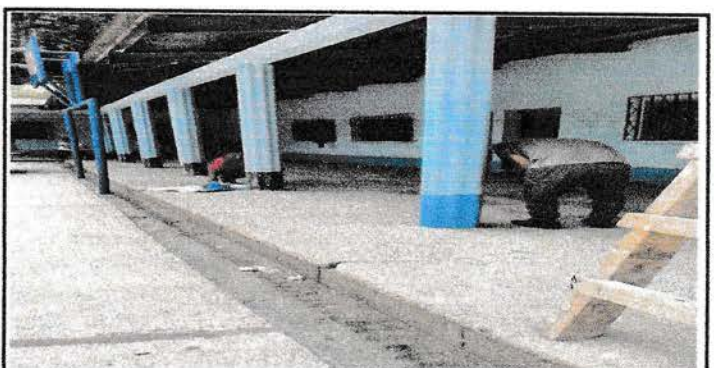
Foto 6: APLICACIÓN DE PINTURA EN MUROS EXTERIORES DE AULAS.
