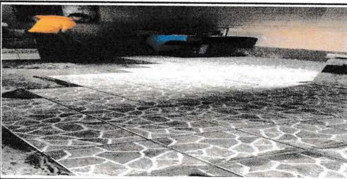
Foto 5: SUMINISTRO E INSTALACIÓN DE PISO CERÁMICO ANTIDESLIZANTE.
