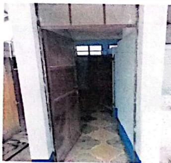
Foto 5: Vista interna de baños generales remozados con aplicación de pintura
