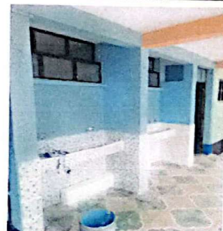
Foto 6: Vista externa de baterías de lavamanos remozados en baños generales
