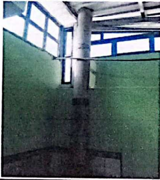
Foto 1: Vista de chimenea de concreto de 6" en esrufa rural terminada y ventanales perimetrales en cocina
