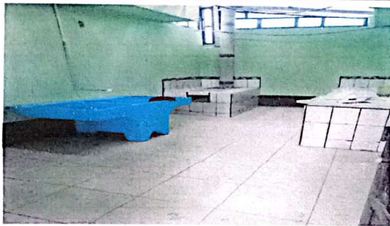
Foto 3: Vista interna de cocina remozada
