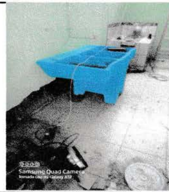
Foto 4: Suministro e instalación de pila de concreto de dos lavaderos con tubería HG en descarga
