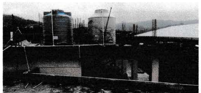
Foto 6: Suministro e instalación de depósito de agua de 1,100 litros + tubería de PVC y accesorios
