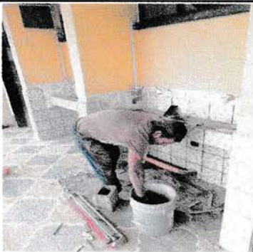
Foto 5: Mejoramiento de baterías de lavamanos en baños generales
