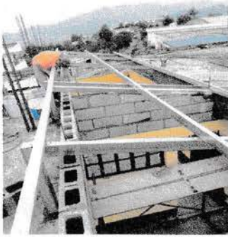
Foto 1: Suministro e instalación de estructura portante de metal con costaneras galvanizadas de 4"x2" y 3"x2"
