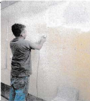
Foto 3: Preparación de superficie para resane de grietas con material elastomérico en muros de cocina
