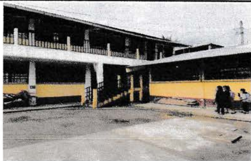
Foto 5: Vista de los valcones en ventanas
