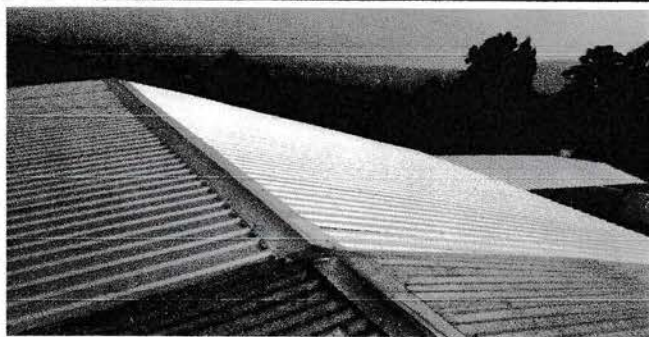
Foto 1: Vista del techo del aula y de los servicios sanitarios
