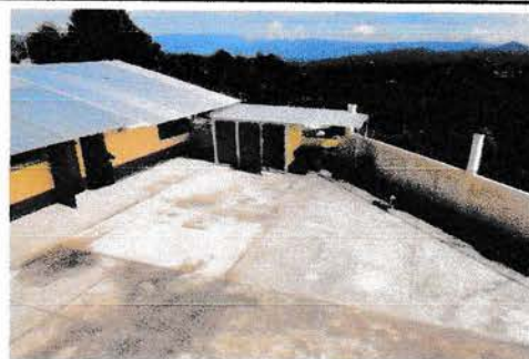
Foto 6: Vista de la torta de concreto, techo del aula y los baños, paredes de mampostería de baños.
