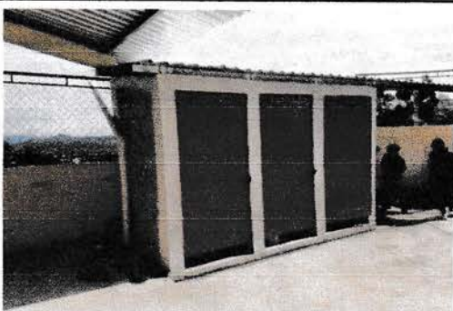
Foto 3: Vista de los baños con paredes de mampostería y tres puertas de metal
