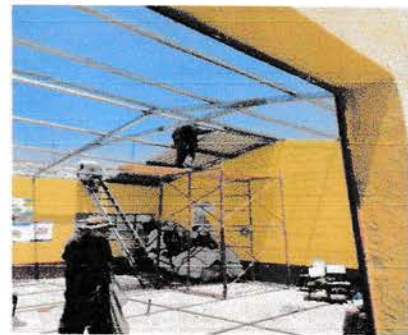
Foto 10: Instalación de lamina y capotes troquelada calibre 26
