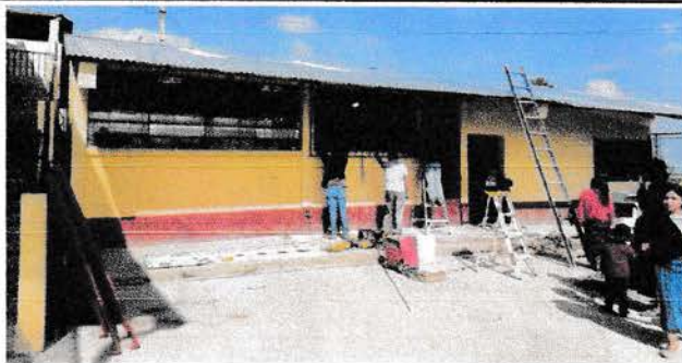
Foto 11: Instalación del sistema eléctrico.
