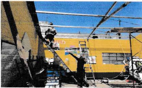
Foto 9: Instalación de estructura de soporte con tubo de metal galvanizado Calibre 16.
