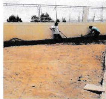
Foto 12: Nivelación del terreno para fundición de torta de concreto
