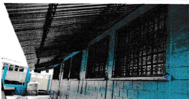
Foto 4: FINALIZACIÓN DE INSTALACIÓN DE BALCONES
