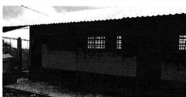
Foto 2: VISTA DE INSTALACIÓN DE LÁMINA FINALIZADO
