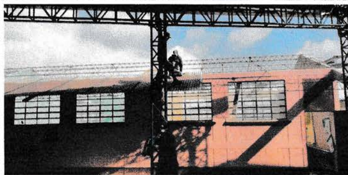
Foto1: RETIRO DE LÁMINAS ANTIGUAS
