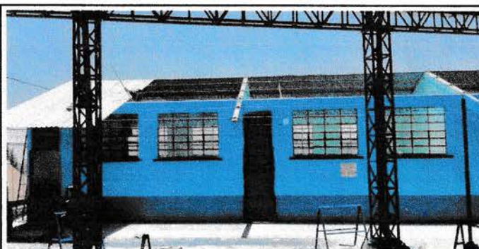
Foto 6: COLOCACIÓN DE LÁMINAS TROQUELADA CALIBRE 26
