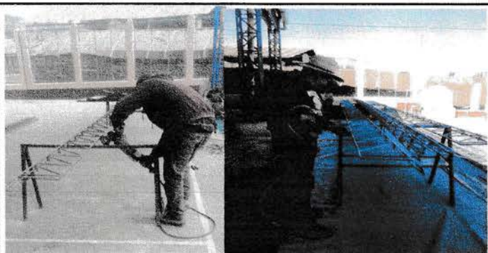
Foto 3: SEPILLADO, LIJADO Y PINTADO DE YOIS
