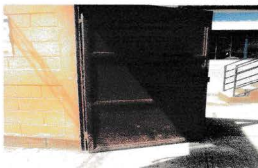
Foto 4: MANTENIMIENTO DE PUERTAS
