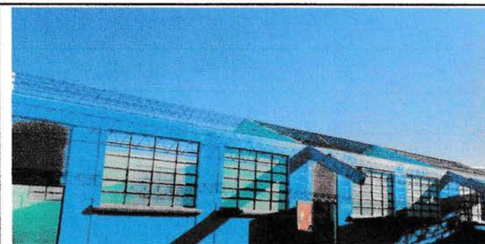
Foto 5: INSTALACIÓN DE YOIS PINTADO
