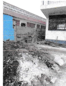
Foto2: LEVANTADO DE MURO PERIMETRAL DE MAMPOSTERIA
