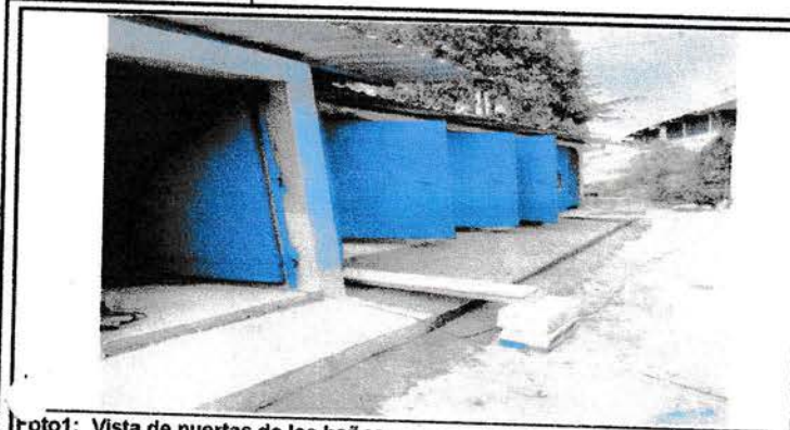
Foto 1: Vista de puertas de los baños
