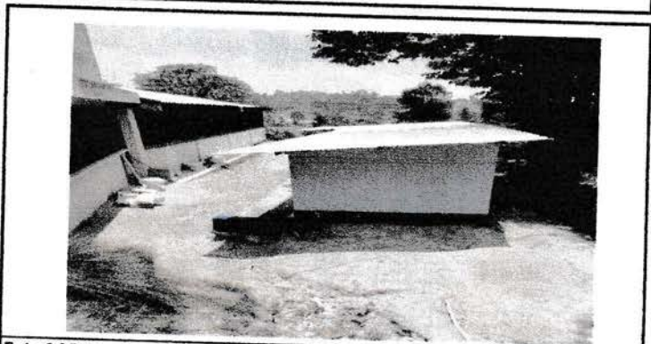
Foto 3: Vista exterior de techo de baños
