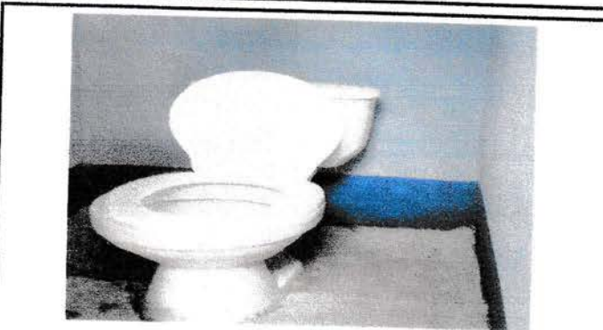
Foto 4: Vista de sustitución de inodoros
