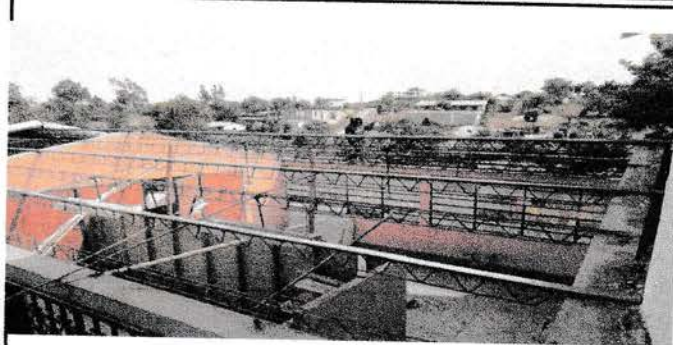
Foto 2: Láminas quitadas del techo
