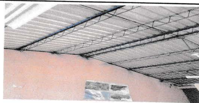
Foto 6: Finaliza la colocación de láminas
